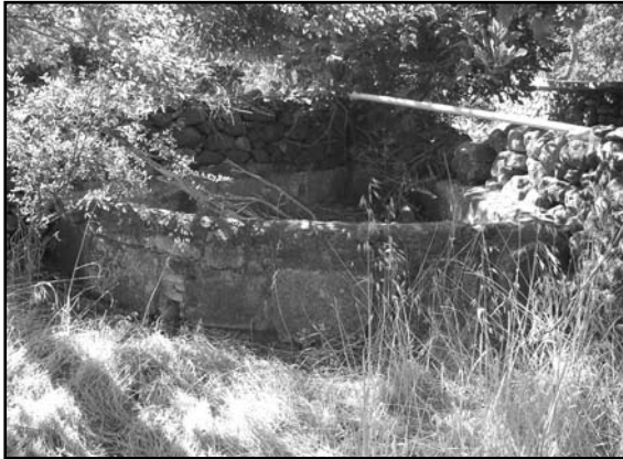
Resim 10: Sulama havuzundaki kemer blokları
