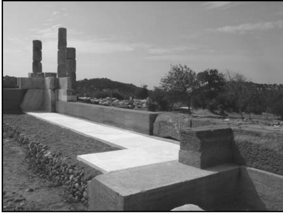
Resim 13: Restorasyon sonrası tapınak sellası döşeme blokları
