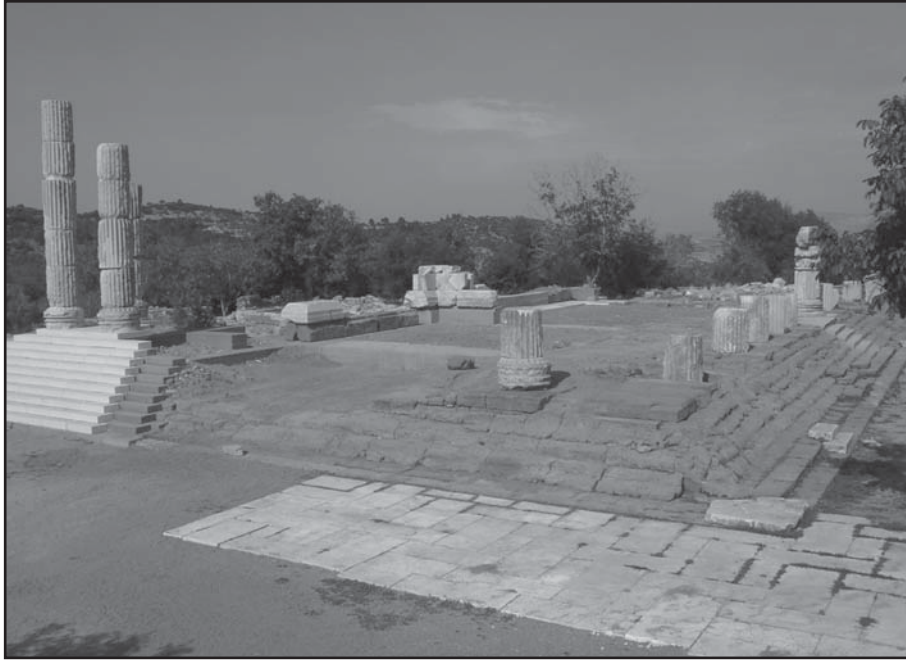
Resim 11: Tapınak pronaos tuf temellerin restorasyonu
