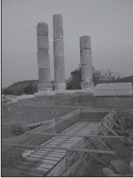
Resim 9: Tapınak pronaos tuf temellerin restorasyonu
