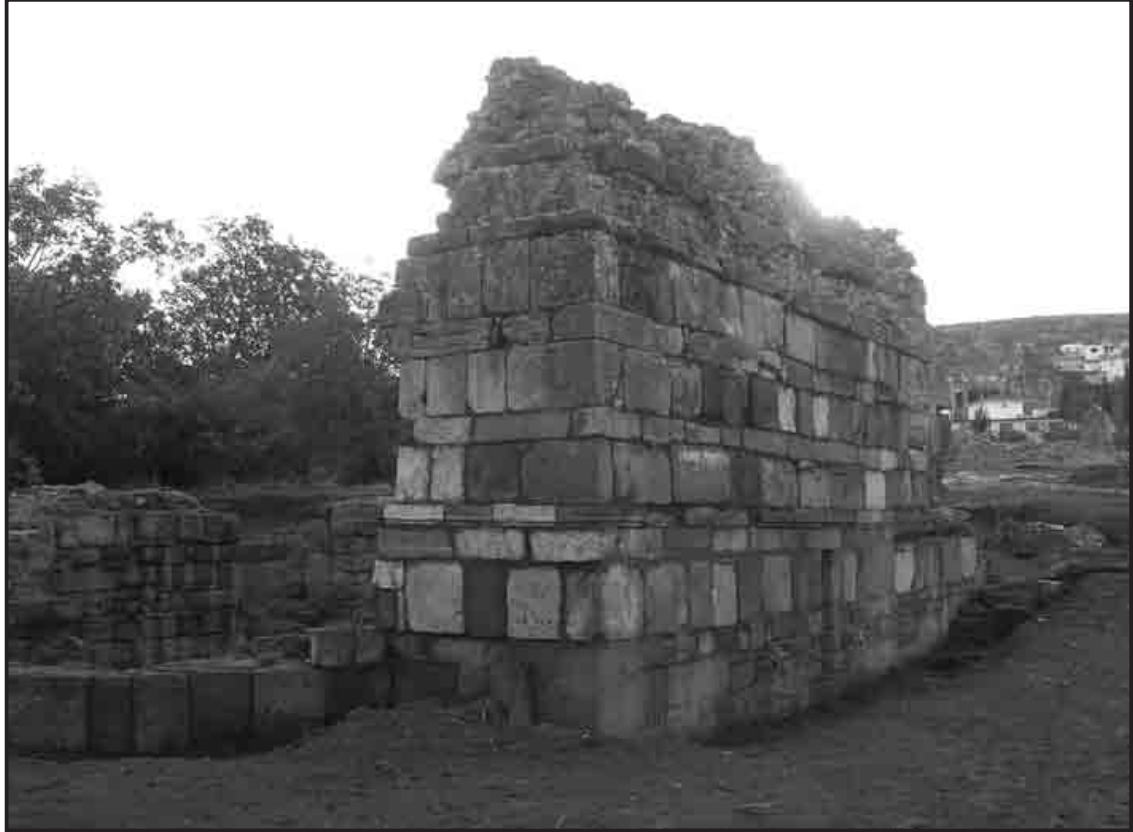
Resim 9: Roma hamamı. Caldarium arka cephe. Restorasyon sonrası
