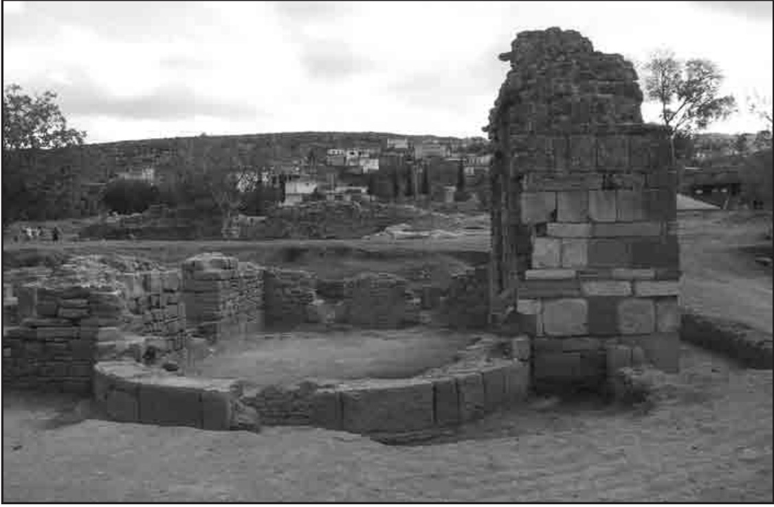
Resim 6: Caldarium . Batıdan görünüşü
