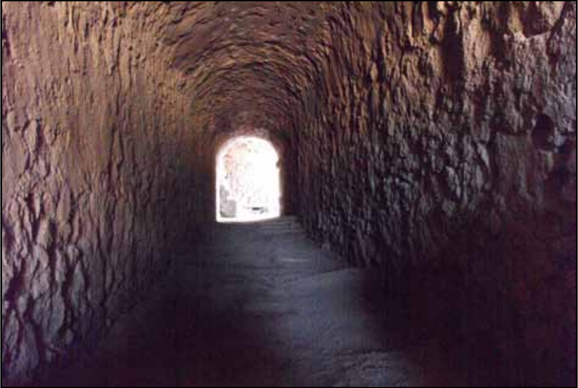
Resim 12: Roma hamamı hizmetli koridoru. İerden (onarım sonrası)
