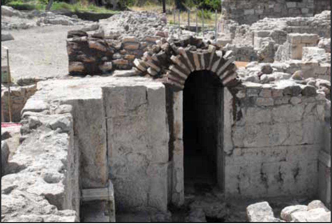
Resim 11: Roma hamamı hizmetli koridoru. Apodyterium girişı (Onarım sonrası)
