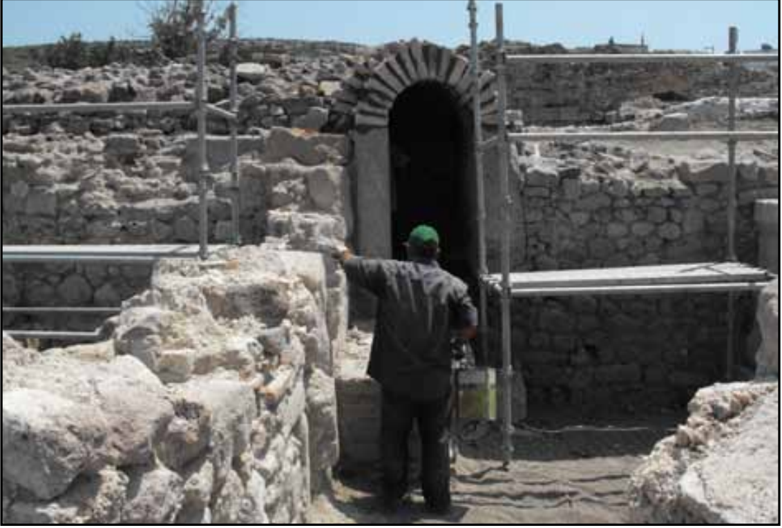
Resim 9: Roma hamamı hizmetli koridoru. Külhan girişi onarımı
