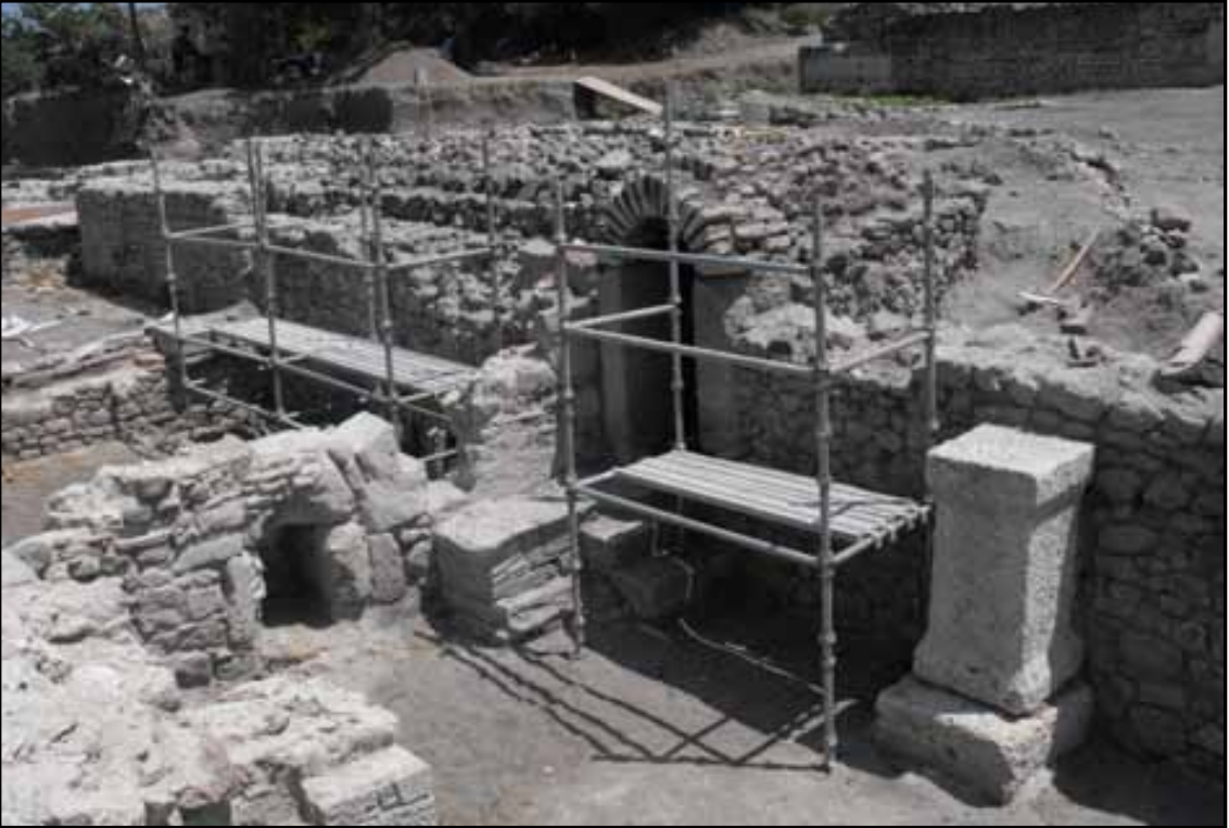
Resim 10: Roma hamamı hizmetli koridoru. Külhan girişi onarımı
