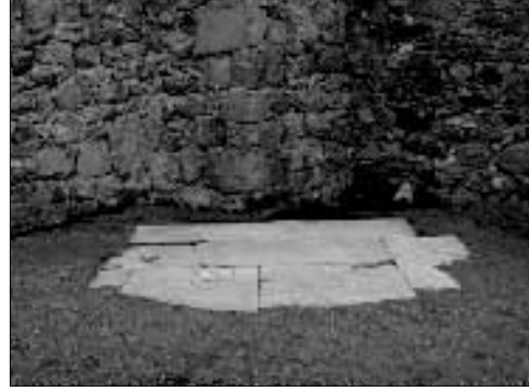
Resim 8: Tapınak temenos taban döşemesi onarım çalışmaları sonrası görünüm
